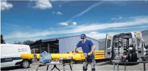
Vorbereitende Arbeiten an einem PE-Rohr zur künftigen Versorgung mit Wasserstoff. FOTO: SASCHA HAUKE
